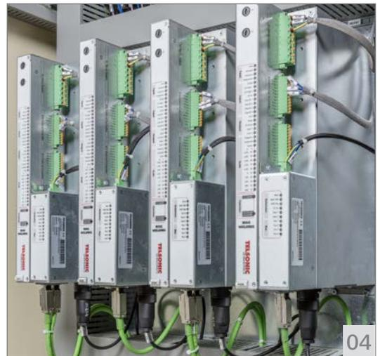
04 Ultraschallgeneratoren der Baureihe MAG mit Busmodulen
